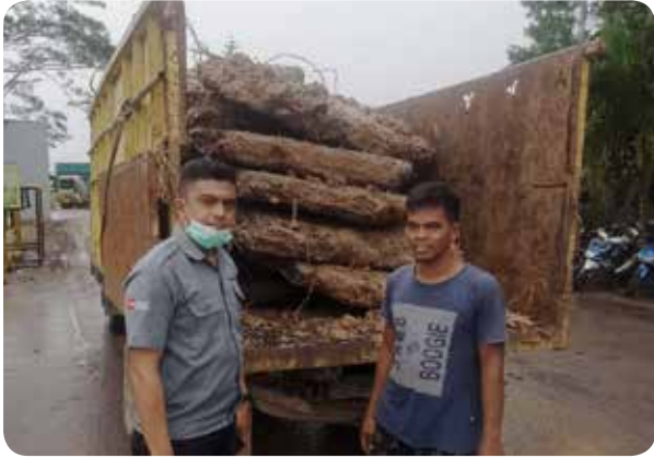
Bantuan pecahan cor beton untuk perbaikan jalan di RT 05 Dusun 01 Desa Mendis Jaya. Donation of cast concrete fragments for road repairs in RT 05 Dusun 01 Mendis Jaya Village.
